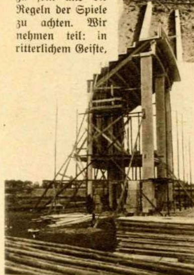
Die hochansteigenden Tribünen der großen Kampfbahn im Entstehen
