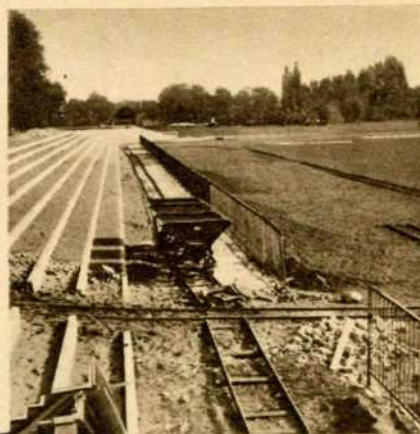
Die fast fertige Sportplatzanlage im Innern des Olympiastadions
