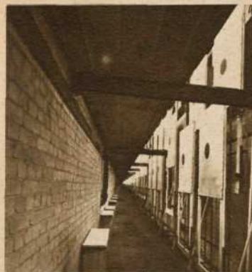
Die Anzeigerbedungen sind in den Boden versenkt, so daß die Zugwechsel-Scheiben während des Schießens ohne Gefährdung der Bedienung ausgewechselt werden können
