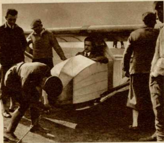
Das Gummiseil wird am Bug des Segelflugzeuges eingehakt
