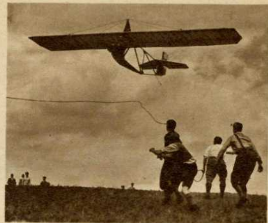
Auf „Los!“ hat die Haltemannschaft das Flugzeug in die Luft schnellen lassen. Nach dem Abfallen des Gummiseiles fliegt die Maschine frei
